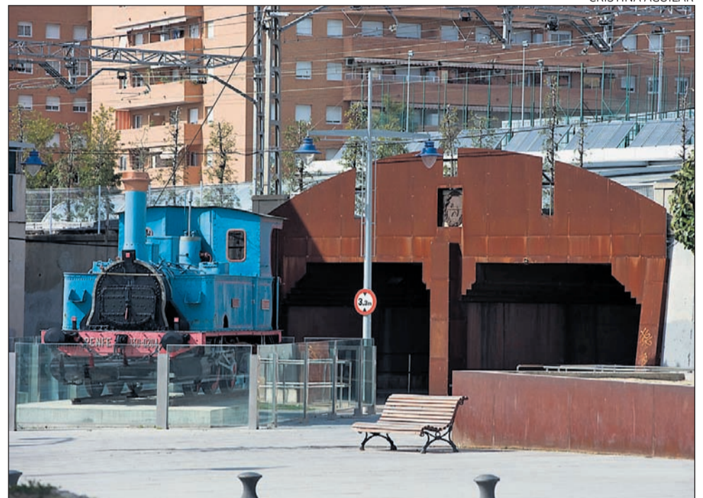
El Pont de la Petxina, ubicat al final del carrer Pere Martell i el Moll de Costa, al barri del Serrallo.
